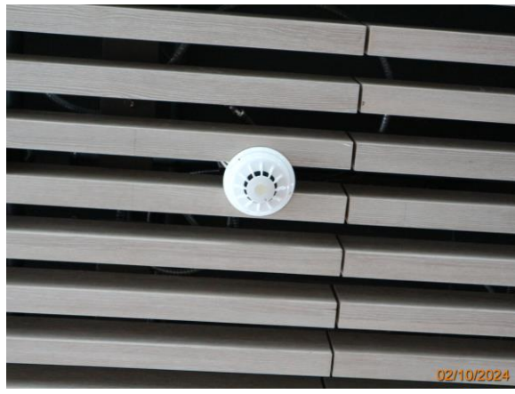
รูปที่ 3-55 เครื่องตรวจจับควัน (Smoke Detector)
