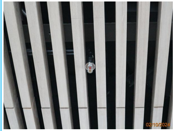
รูปที่ 3-56 หัวกระจายน้ำดับเพลิงอัตโนมัติ
