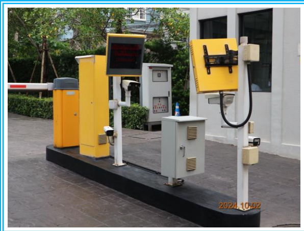
รูปที่ 3-37 ระบบอ่านเลขทะเบียนรถของพนักงานบริเวณทางเข้า-ออก
