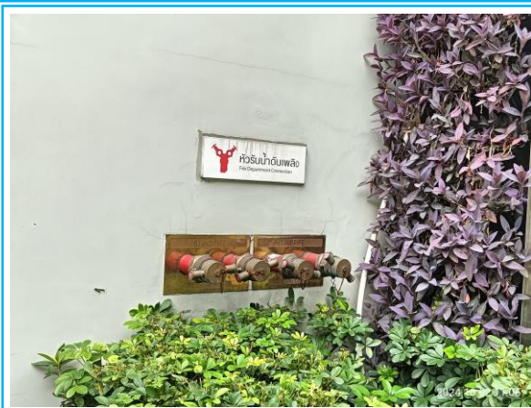
รูปที่ 3-57 หัวรับน้ำดับเพลิงภายในโครงการ
