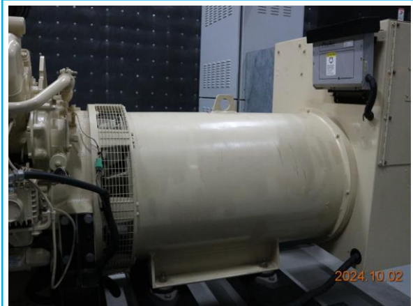
รูปที่ 3-11 เครื่องกำเนิดไฟฟ้าสำรอง
